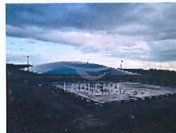
ระบบ Biogas แบบ Modified Covered Lagoon
